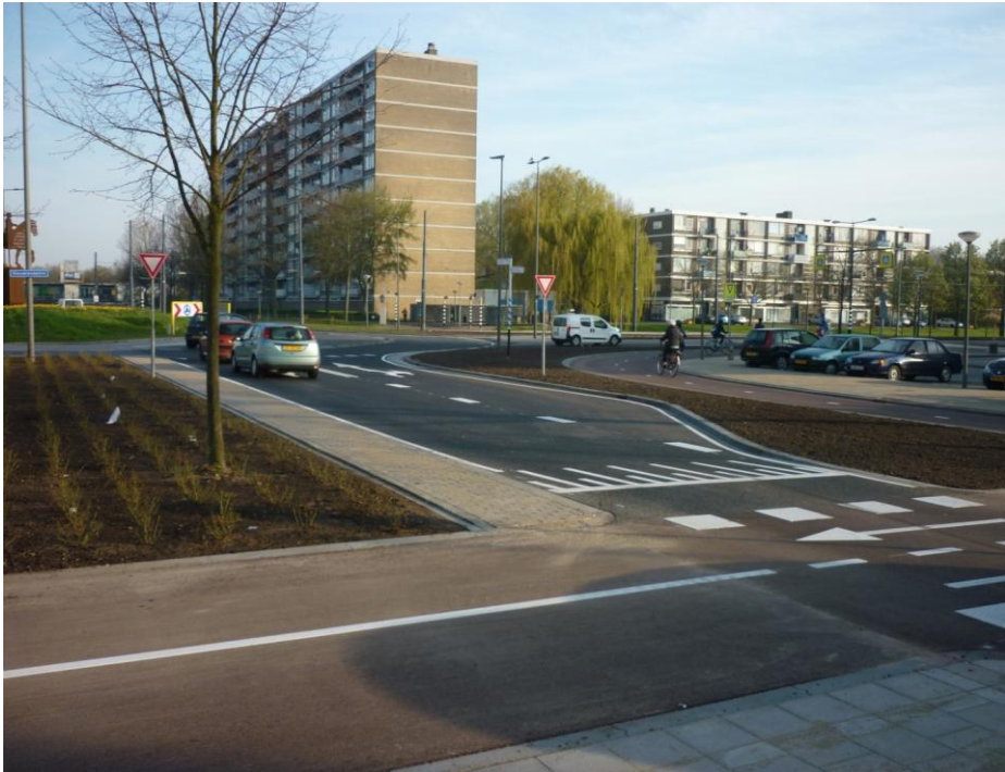
Figuur 4: Terug naar één rijstrook voor het oversteken van langzaam verkeer, behoud van twee rijstroken bij de turborotonde.
