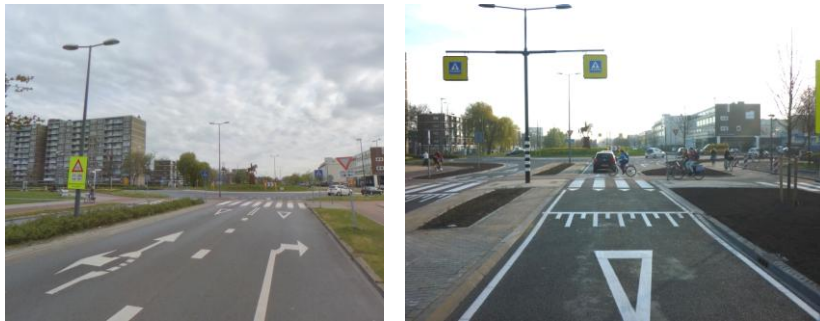
Figuur 3: Nieuwlandplein, gezien vanaf de westzijde (Burgemeester van Haarenlaan): links de situatie voor de herinrichting, rechts na de herinrichting
