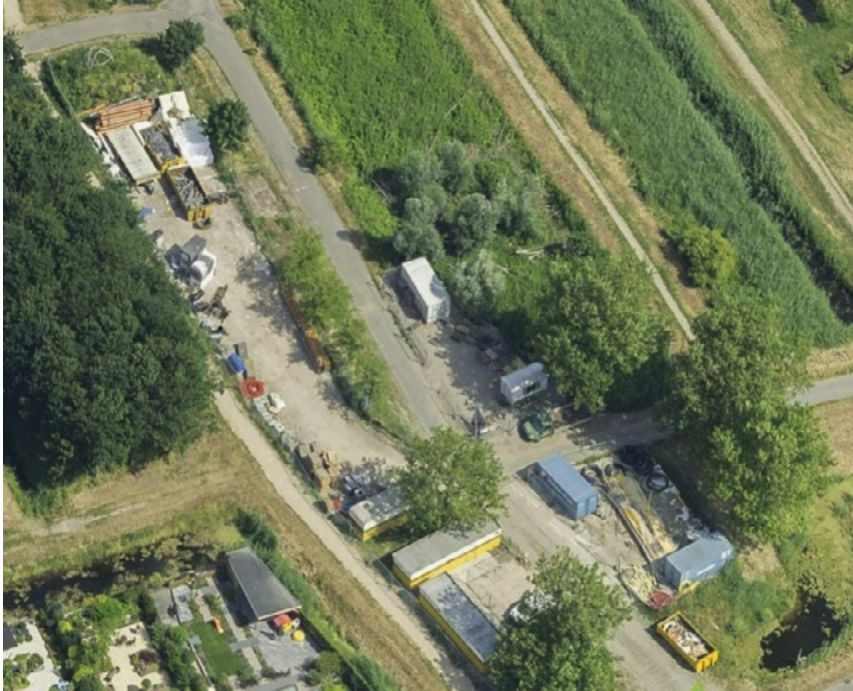
Luchtfoto: opslaglocatie zoals in 2017
