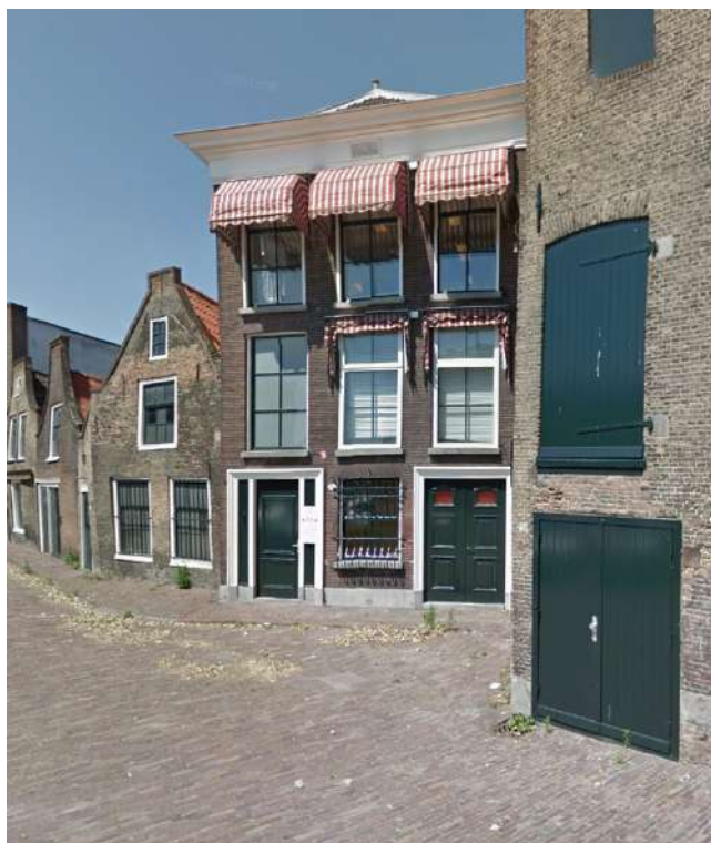
Afbeelding 5. De monumentale panden aan de Zijlstraat 4 t/m 12 (bron: Google maps).
