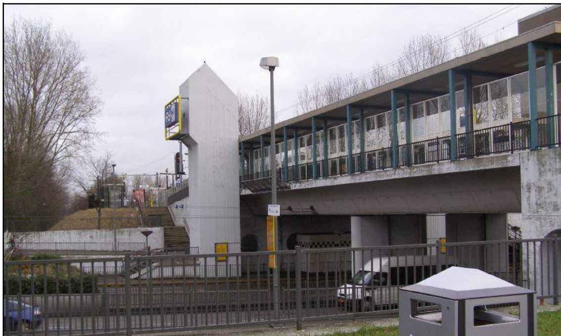
Afbeelding 3: Zicht op station Schiedam Nieuwland.
