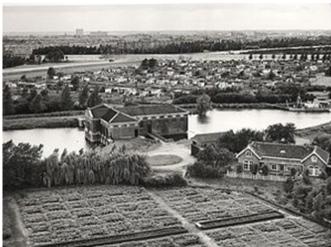
Het Stoomgemaal Van der Goes in 1965 vlak voor de sloop van de bovenbouw. Op de achtergrond Volkstuinvereniging Vijfsluizen.
