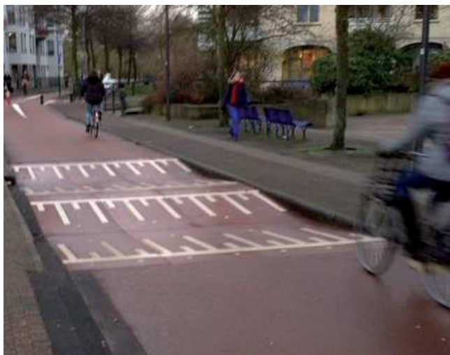
Figuur 4.9 - Principe van een bromfietsdrempel Bron: Wilmenga, J., 2015
