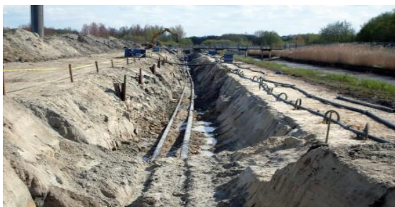
Afbeelding 2 Aanleg pijpleiding met een open ontgraving (bron: www.civilengengroup.com , datum 1 juni 2012)
