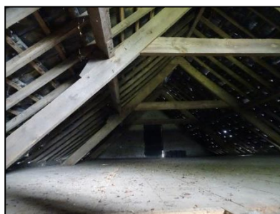
Figuur 13. Zolder oudere schuur.
