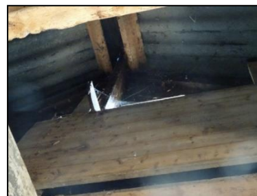
Figuur 35. Ruimte tussen de nok en de binnenzijde van het dak bij betimmerde schuur (nummer 3).
