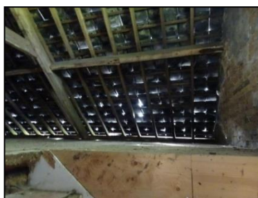
Figuur 37. Dak en openingen aan het dak zichtbaar bij de oude schuur (nummer 4).
