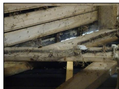
Figuur 27. Detailfoto van het dakbeschot met nestmateriaal tussen het dakbeschot en het dak.
