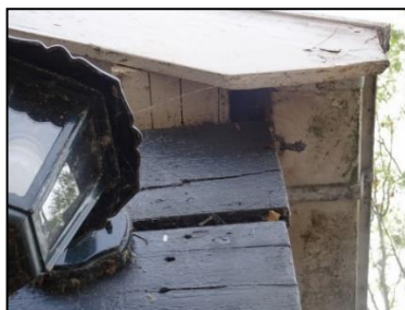
Figuur 34. Andere opening onder daklijst bij betimmerde schuur (nummer 3).
