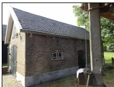
Figuur 12. Noordzijde oudere schuur.
