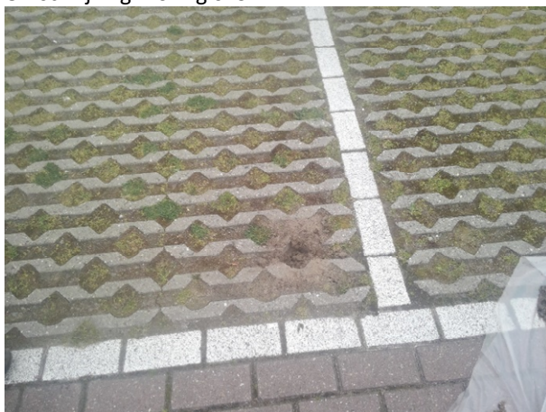
Fotonummer: 15 Omschrijving: Boring 024A
