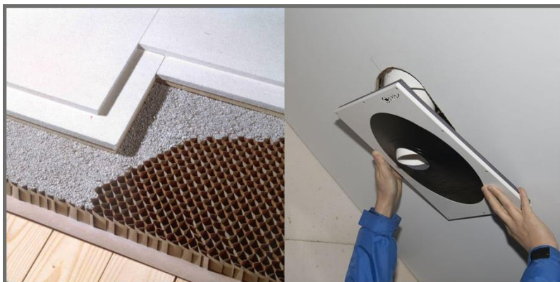
Figuur 5: i) Droogbouw met Eermacell ii) kierdichting van Celdex Airseal
