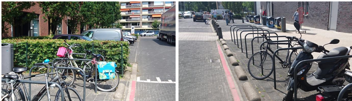
Inrichting parkeerstrook Valeriusstraat: afscheidende hekwerken en heggen, biggenruggen en magneetstrip
