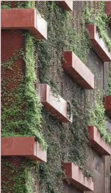
Groen onderdeel van de gevel
