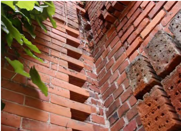
Openingen in metselwerk
