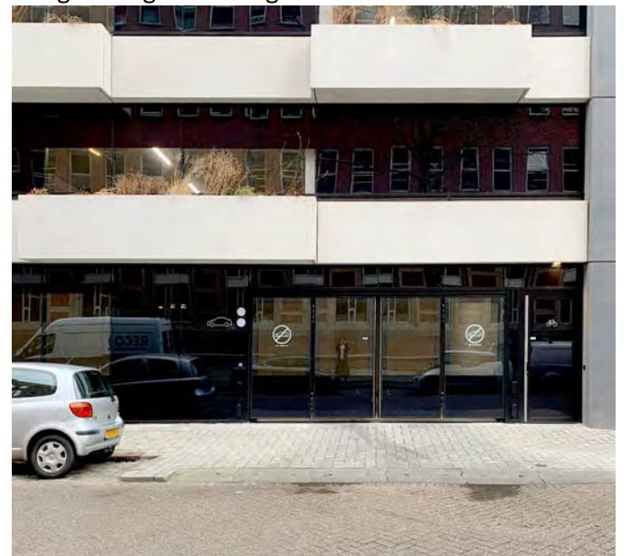
Technische ruimtes en installaties zijn meeontworpen
