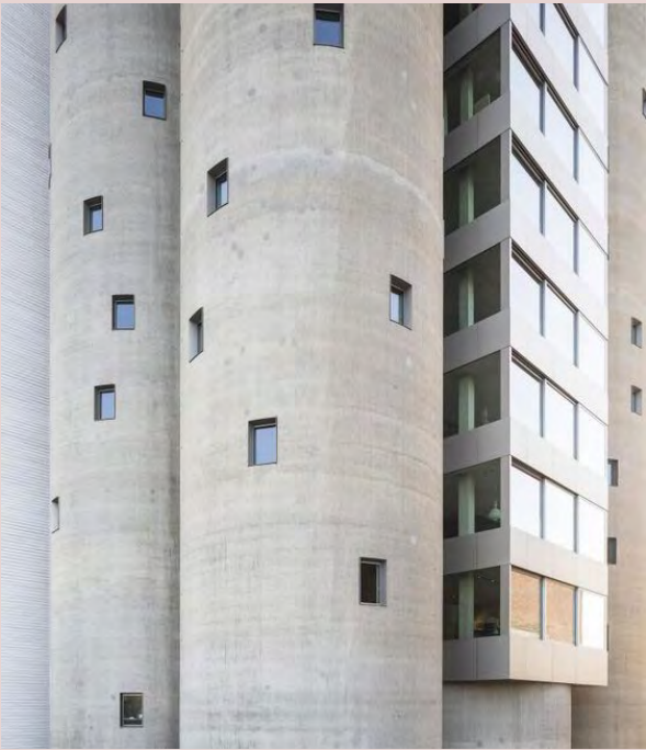
Combinatie tussen bestaand en nieuw
