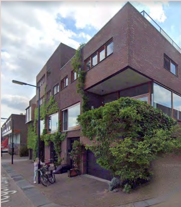
Incidenteel werken met erkers, grotere vensters en open loggia's
