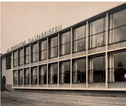
Hoofdgebouw de glasfabriek
