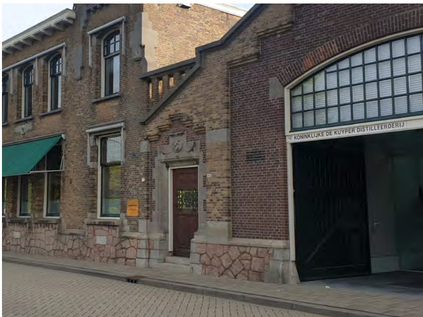
Voorbeelden van de kwaliteit van de plinten van de bestaande fabriek en de omgeving.
