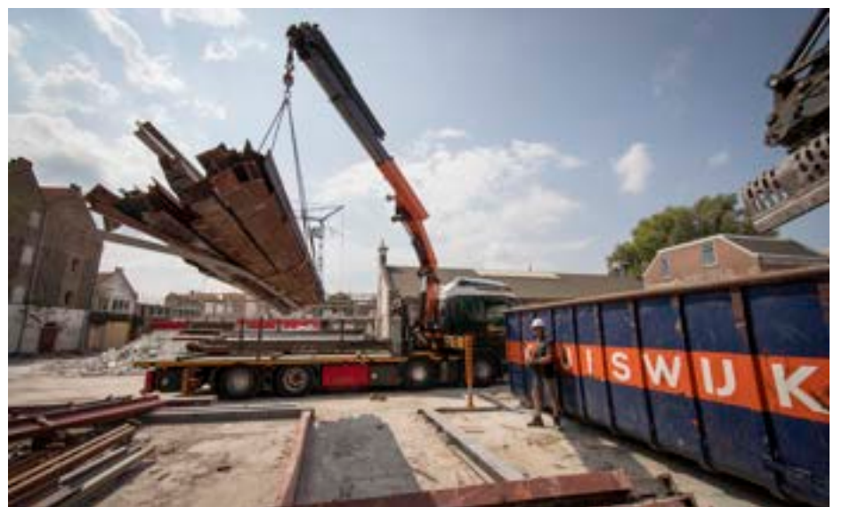
Sloopmaterialen worden gescheiden en waar mogelijk hergebruikt
