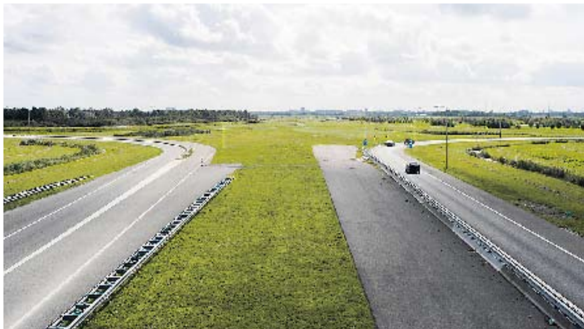
Het begin van de verlengde A4 zoals dit er al jaren bij ligt. Foto: Hollandse Hoogte/Ries van Wendel de Joode
