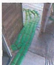
Nieuwbouw woning Heino
