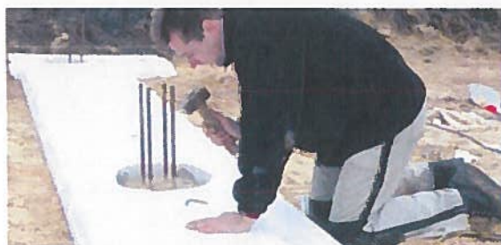
3 Met bodemplaten verbindingen maken tussen de hoeken.
