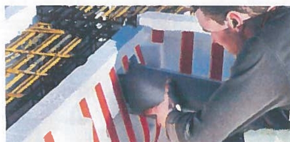
5 Eventuele sparingen maken en zijwanden plaatsen.
