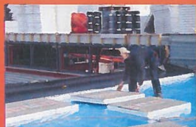
plat dak isolatie
