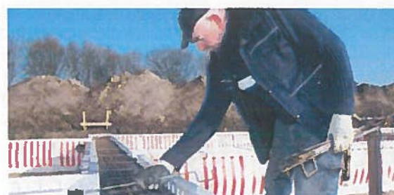
6 Bovenbeugels aanbrengen, ca. 600 mm h.o.h.
