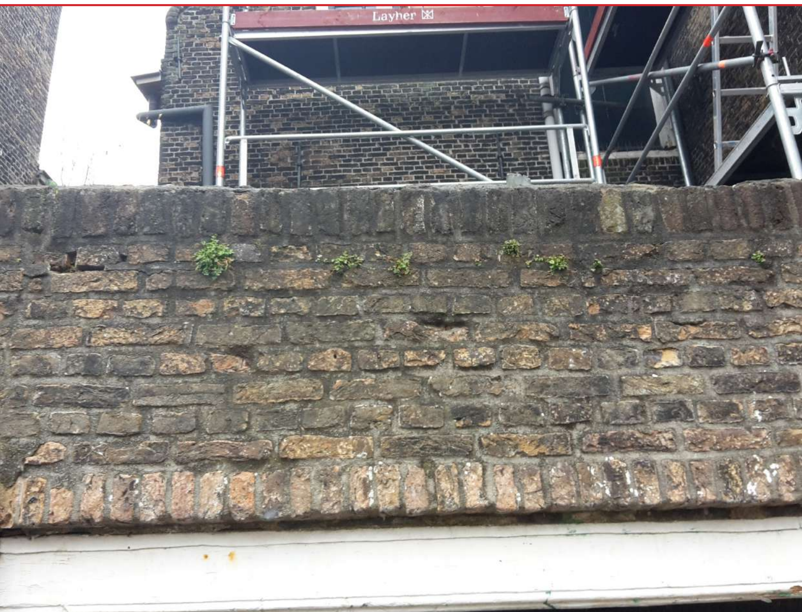
Beeldimpressie projectgebied: muurflora op de buitenmuur van de patio
